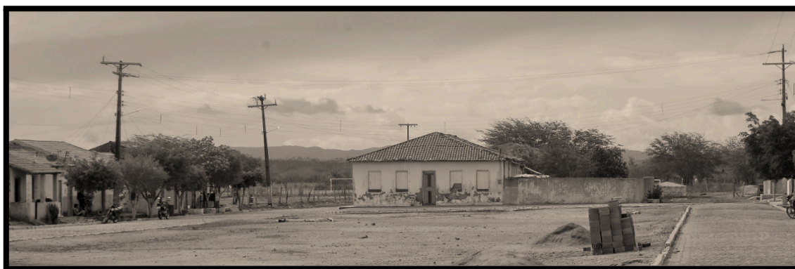
Terreiro central e casario do Povoado Cipó de Leite, no município de Pedro Alexandre, na Bahia. Ao fundo, emoldurando a paisagem do lugarejo, a soberba Serra Negra, entre o nordeste da Bahia e o noroeste de Sergipe (Fotografia: Samuel Albuquerque, 15 de abril de 2017)
