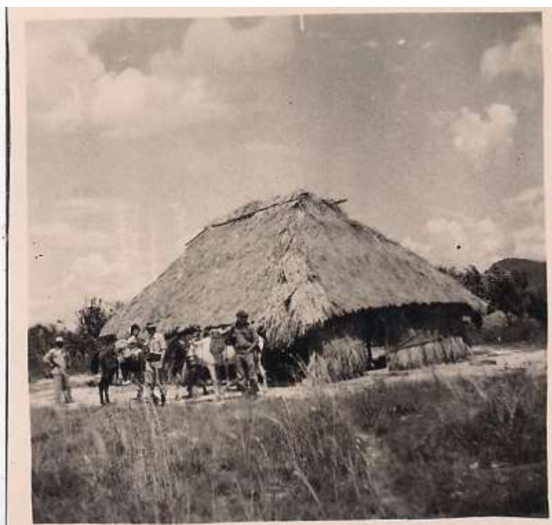
Foto 14. Outra fazenda com a cobertura já gasta. Em geral as palhas duram de 2 a 3 anos devendo ser refeitas e as casas serem novamente cobertas.
